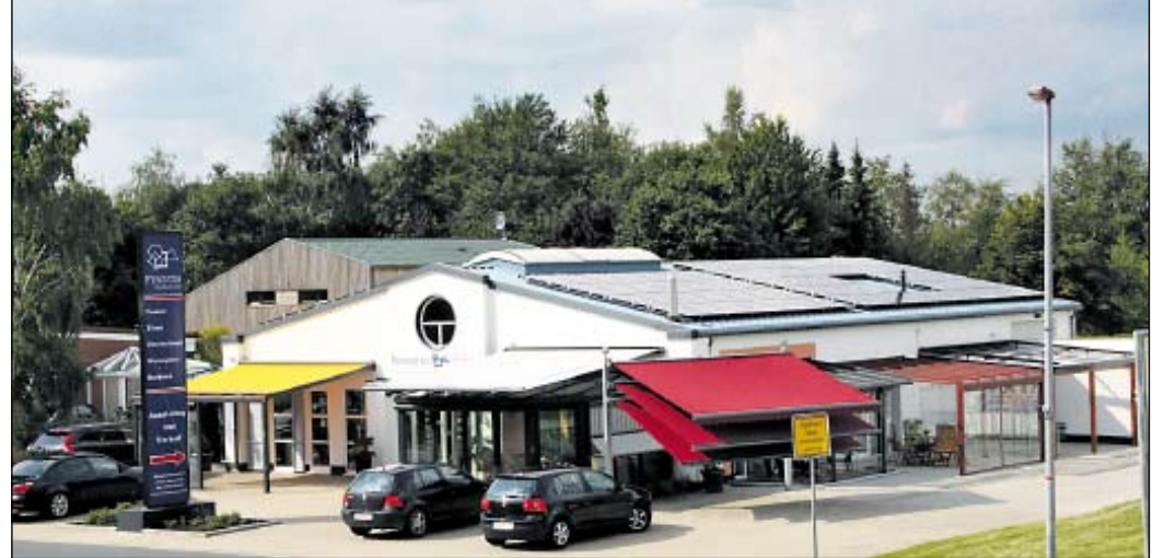
„Fenestra Nordwest“ hat das Firmen-Domizil in der Schuhmacherstraße energetisch auf den neuesten Stand gebracht. Foto: Andreas Meinders
